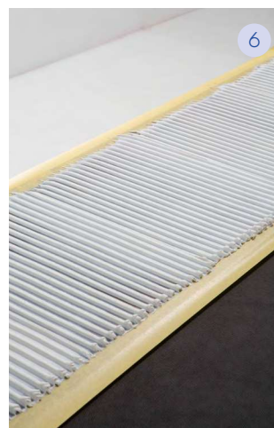
6 Stendere LITOELASTIC EVO in modo uniforme sulla superficie.
