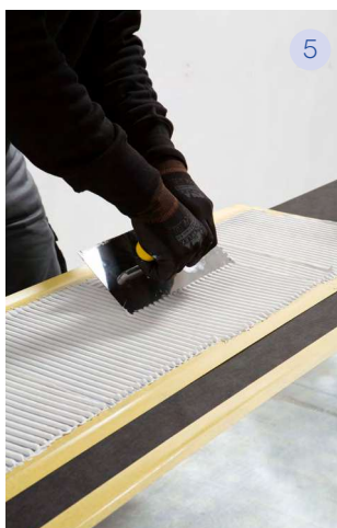
5 Applicare LITOELASTIC EVO sul retro della lastra con spatola dentata da 3,5 x 3,5 mm, distribuendo il prodotto nel senso del lato corto.
