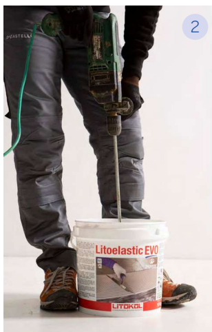
2 Mescolare LITOELASTIC EVO come indicato nella scheda tecnica.
