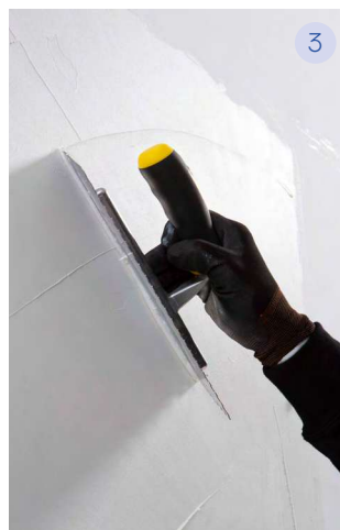
3 Applicare LITOELASTIC EVO sul supporto con spatola liscia, senza lasciare residui di adesivo.
