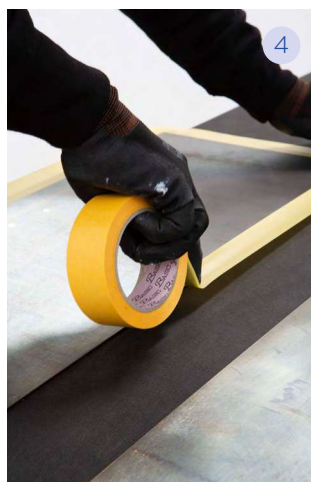
4 Utilizzare nastro adesivo di carta per proteggere il bordo (1-2 cm).
