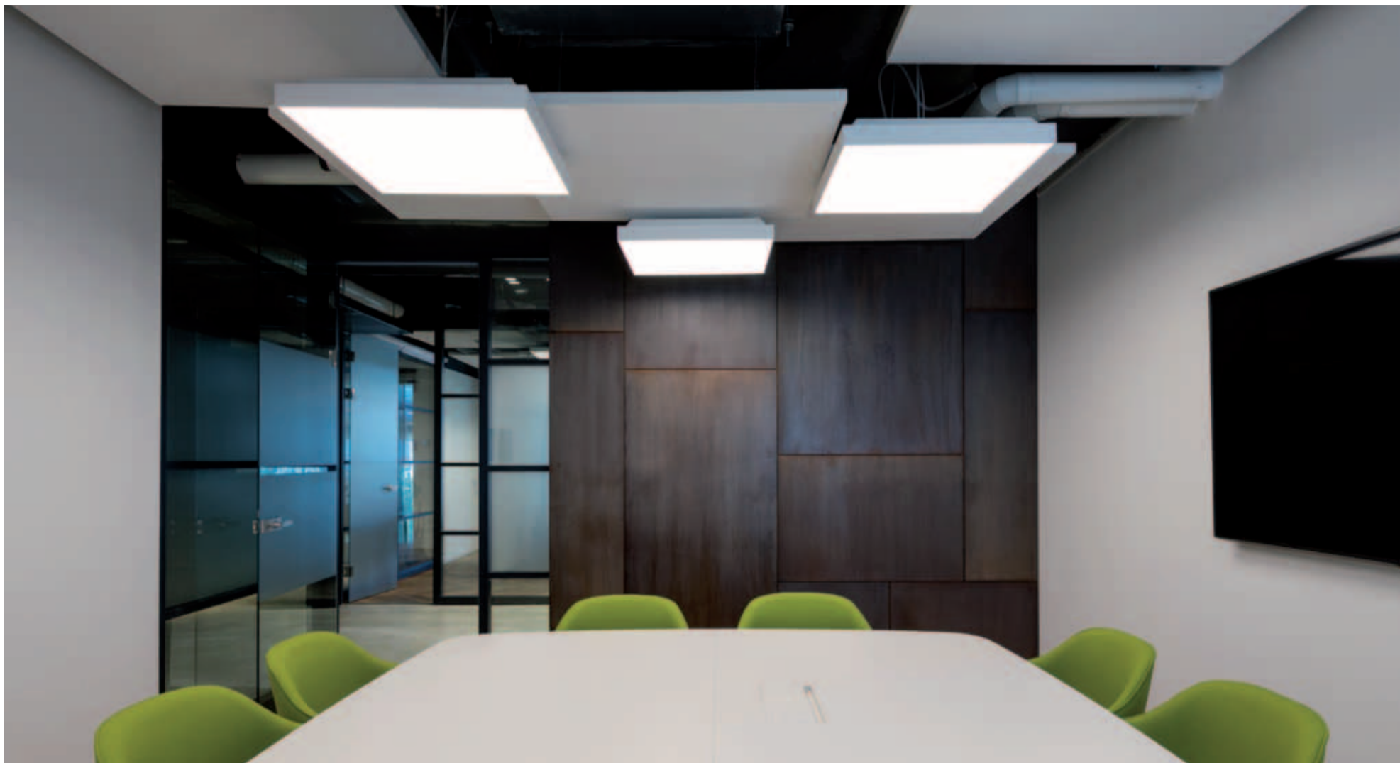
Particolare dell'ufficio, parete boiserie in COR-TEN cerato A detail of the office, the boiserie wall in waxed COR-TEN
