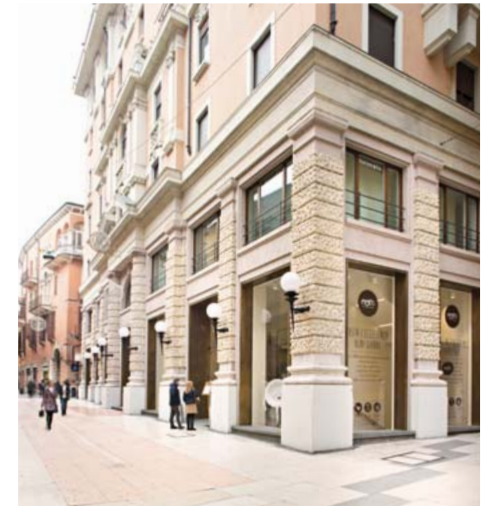
Rivestimento intradosso delle vetrine in ottone acidato Intrados covering for the displays in acid-etched brass
