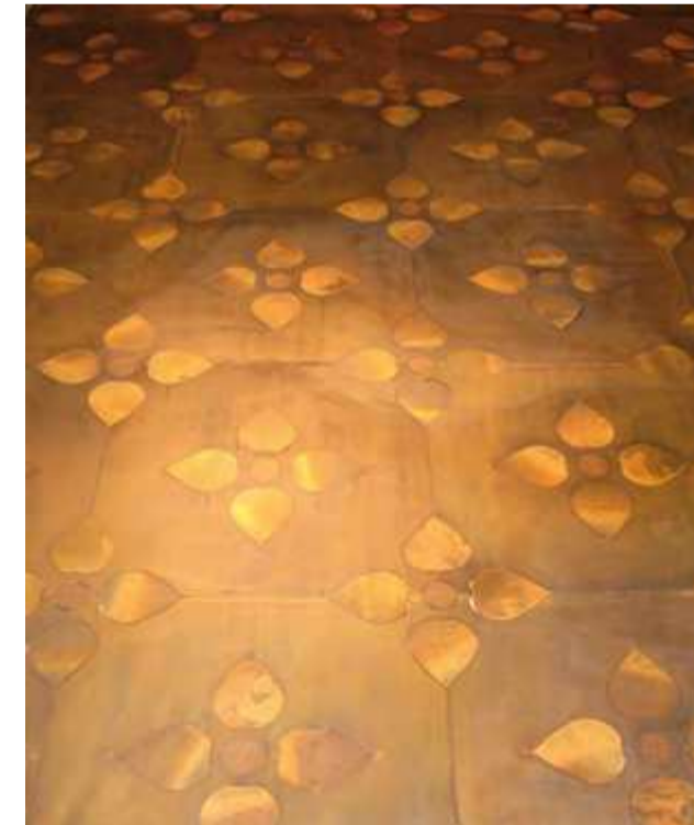
Made (Milano) Pavimento intarsiato in COR-TEN COR-TEN inlaid floor
