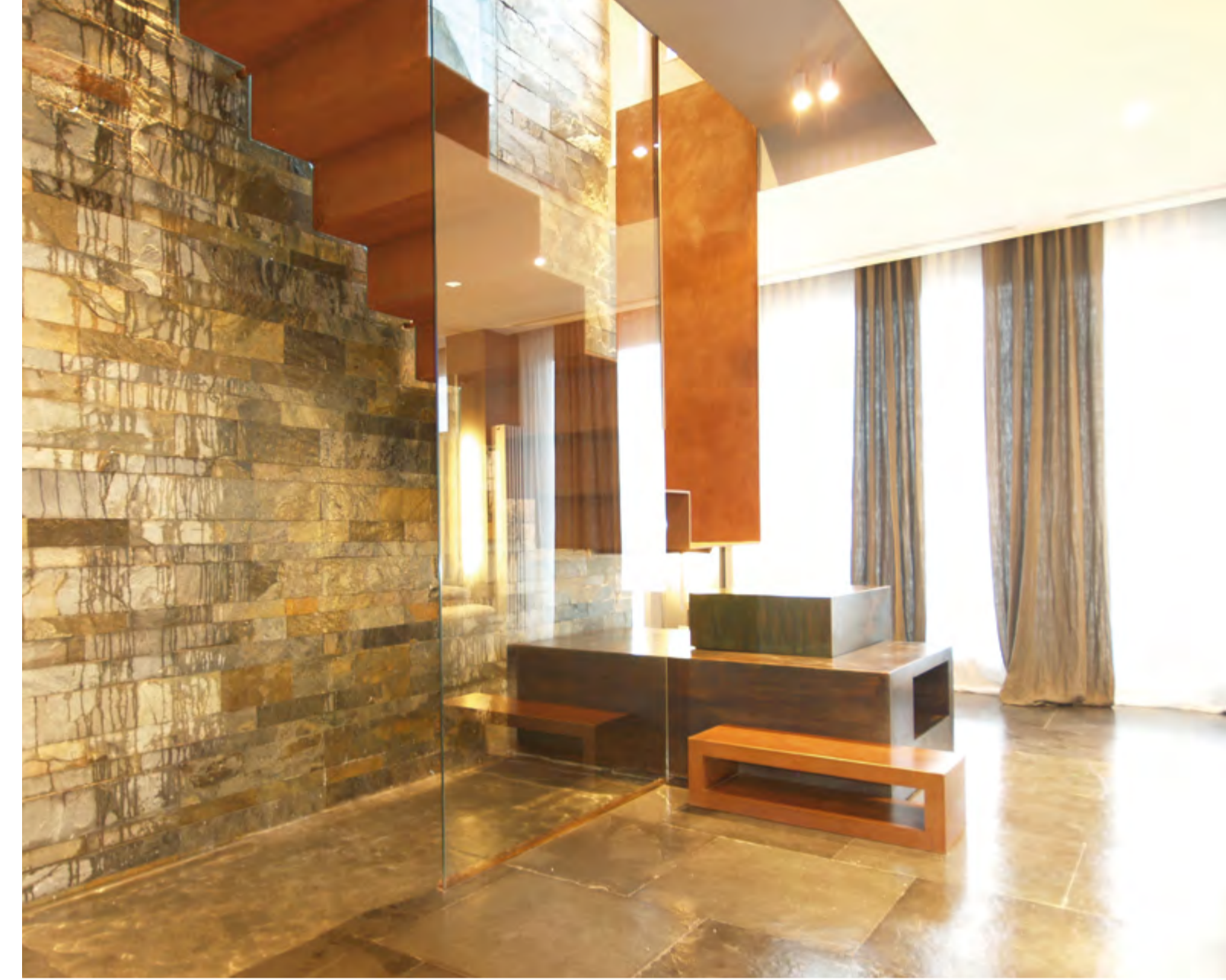
Abitazione Privata (Roma) / Private house (Rome) Scala sospesa in COR-TEN cerato Waxed COR-TEN suspended staircase
